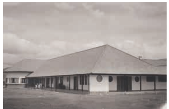
Een gedeelte van het nieuwe gebouw in Wonosobo, dat op 7 februari 1939 ingezegend werd.
